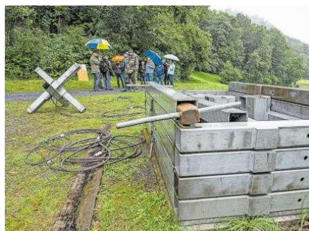
Eine Sperrstelle mit Stahlspinne wird besichtigt. Bilder: Hansueli Senn
